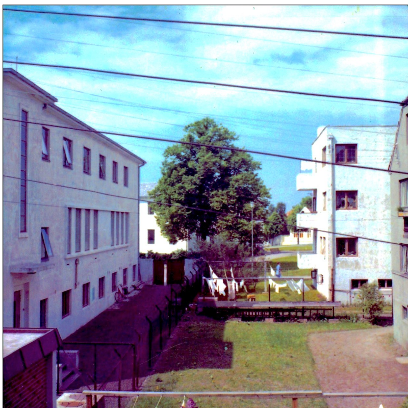
Vikedalsgaten 1 er den lyse bygningen på høyre side. Det henger klesvask på tørkestativet til venstre for huset. Leiligheten Edvin og Wendla leide i tredje etasje før krigen, er ikke synlig. Bildet er tatt i 1963 fra Sandeidgaten 12. Det store treet i bakgrunnen på Sven Oftedals plass var målstang når “ongane i gadå” spilte fotball der.
