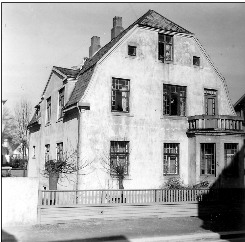
Sandeidgaten 12 1955/56. Vinduene i første etasje har fått innvendige varevinduer og glassplater med gullgul tekst. Strekkantennen for AM-radio er såvidt synlig. På bildet kommer antenneledningen fra Sandeidgaten 9 skrått inn til det store vinduet på loftet og føres så skrått ned til det venstre vinduet i første etasje. For Edvin var antennen viktig siden han gjerne lyttet til radiosendinger fra utlandet. Trærne ved gjerdet er lindetrær. Negativformat: 60mm x 60mm. Foto: Edvin Eikenes
